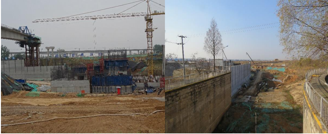
图 3.2-1 东淝河船闸生态环境现状
